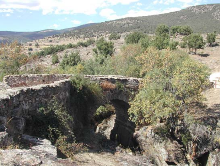
Figura 29: Aspecto del puente medieval del Congosto, construido con gneis sobre el río Lozoya y cimentado sobre gneis.
